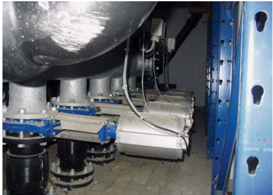
Bild 3. ZETA® Plattenschieber mit Pneumatikantrieben.
