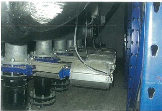
Bild 4: ZETA® Plattenschieber mit Pneumatiktrieben
