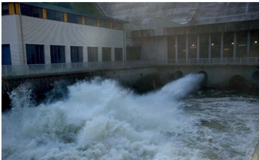
Bild 4: Grundablassbetrieb an der Talsperre Leibis-Lichte mit einem VAG-Ringkolbenventil DN 1 000 mit Belüftungseinrichtung
