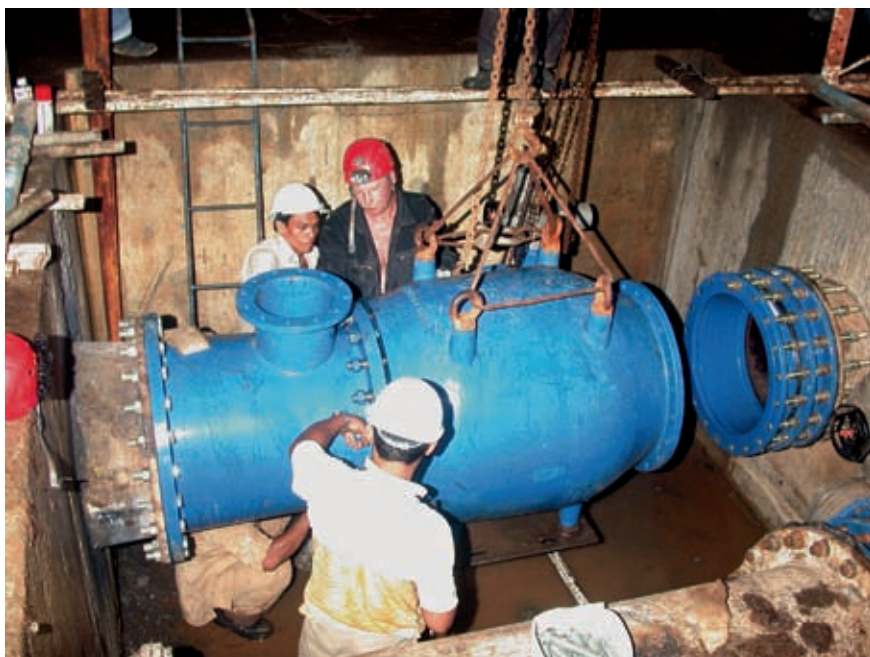
Bild 1: VAG-Ringkolbenventil DN 600 in der Höhle Gua Bribin
